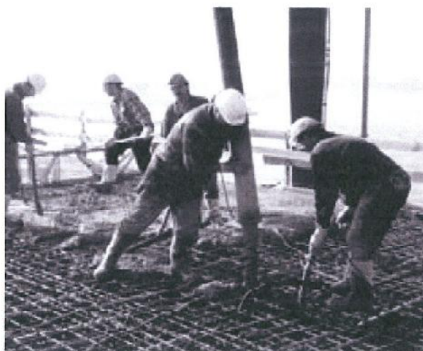
Bild 1: Verarbeiten von Beton auf der Baustelle
